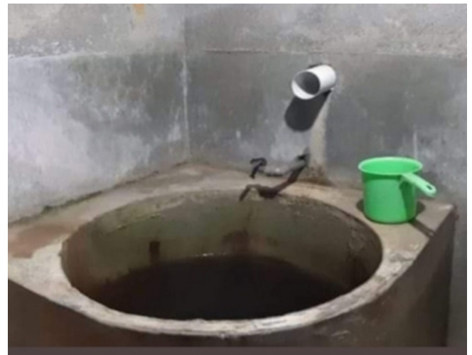
Pemanfaatan air hujan di rumah Kepala Desa Prabu Kecamatan Pujut Kab. Lombok Tengah (Foto: Supriadi Datuk Tumpatih, 2020)
